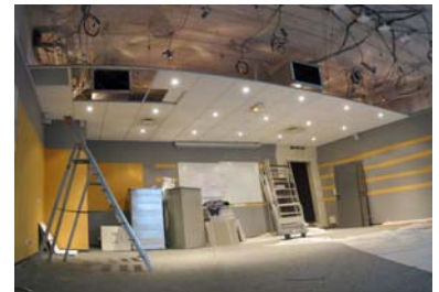
Figure 4: Rehaussement d'une partie du plafond.
