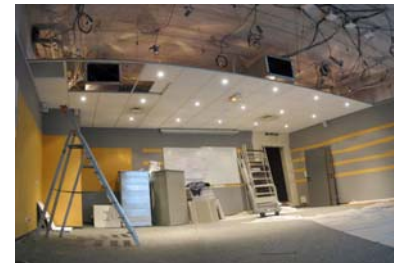
Figure 4: Rehaussement d'une partie du plafond.
